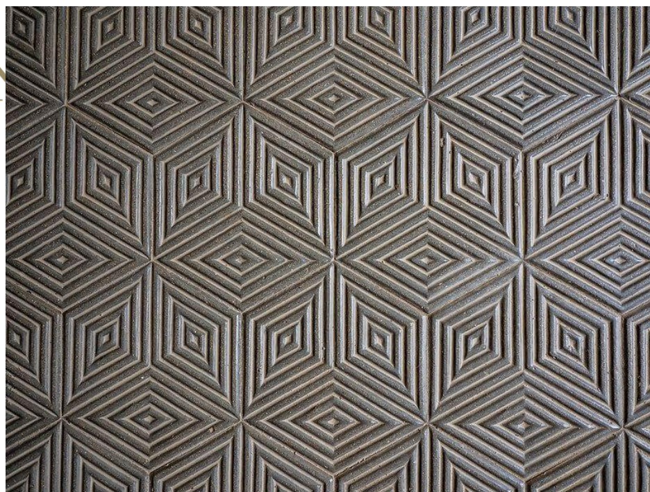
Fig. 17. El pavimento hexagonal de la Torre “Bellesguard”
