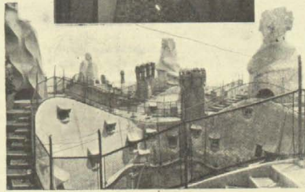
Azotea de la casa Milá, en el Paseo de Gracia
